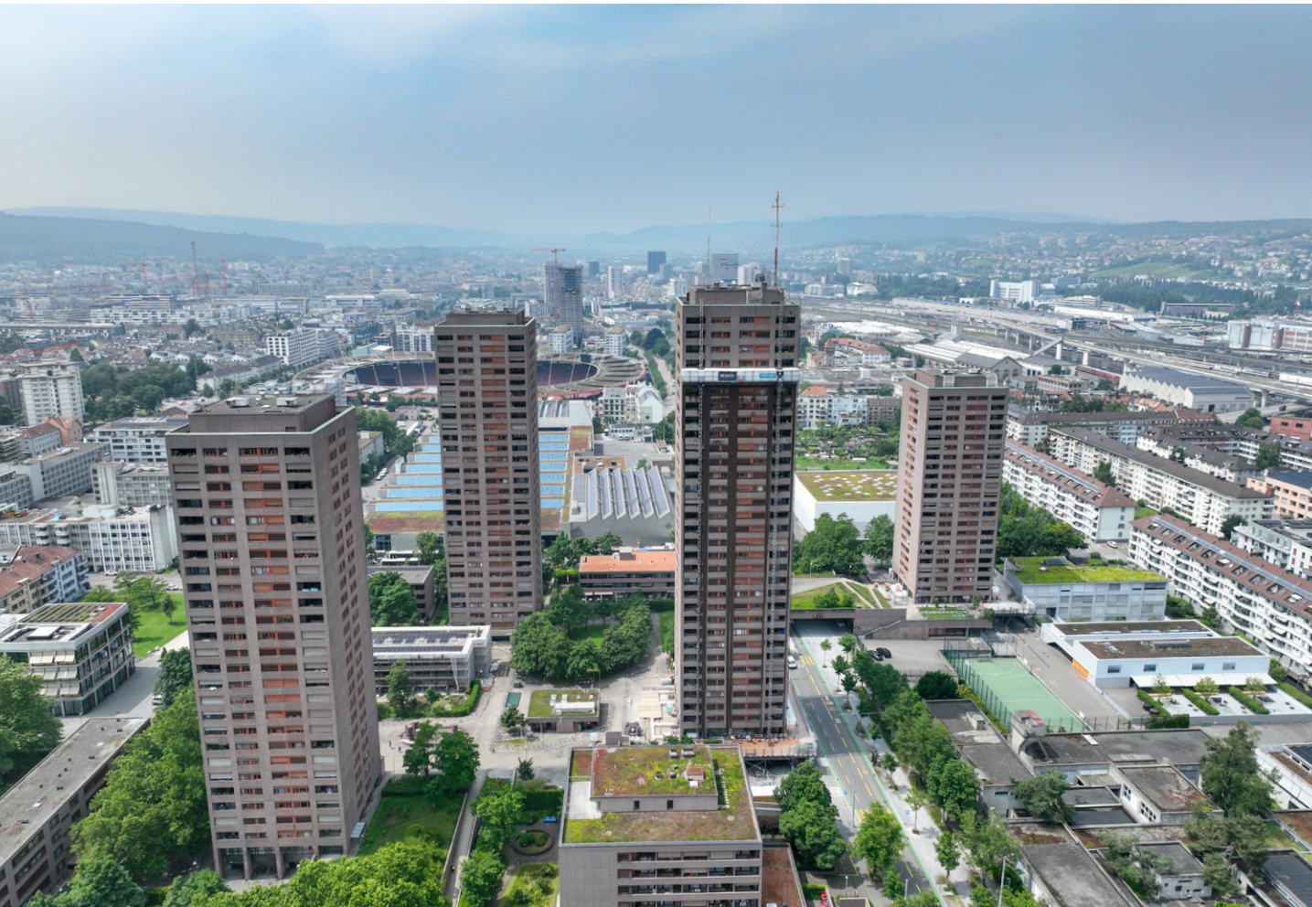
Sanierung Hardau II in Zürich
