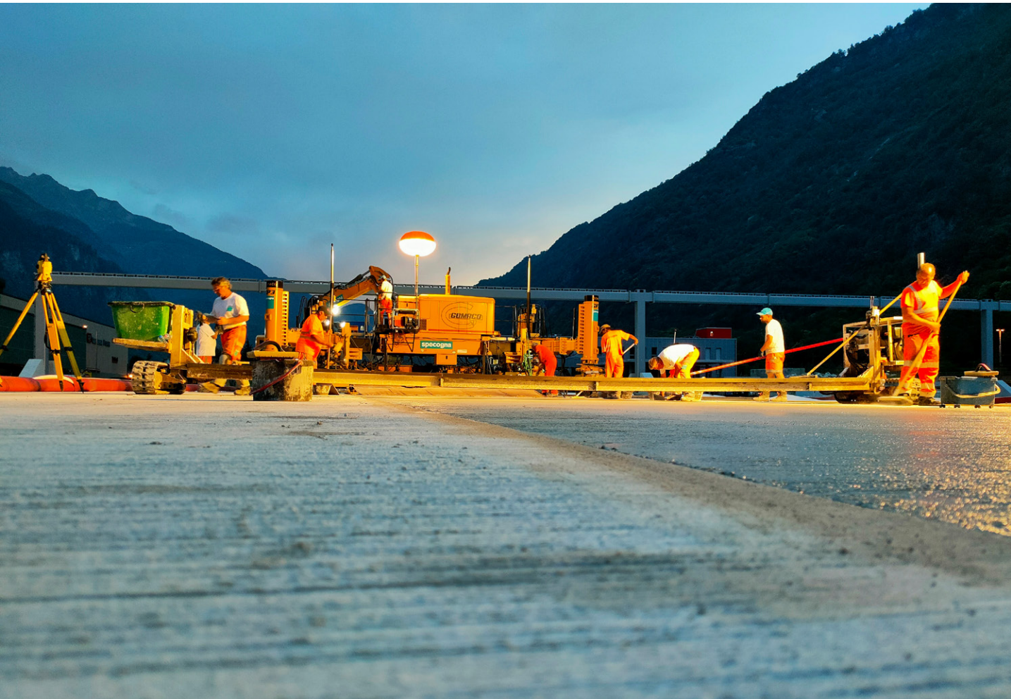
Schwerverkehrskontrollzentrum in Giornico (TI)
