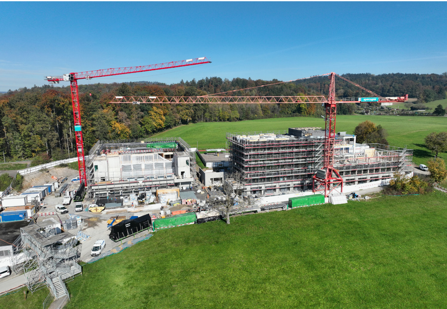
Ersatzneubau Schulanlage Nägelimoos in Kloten
